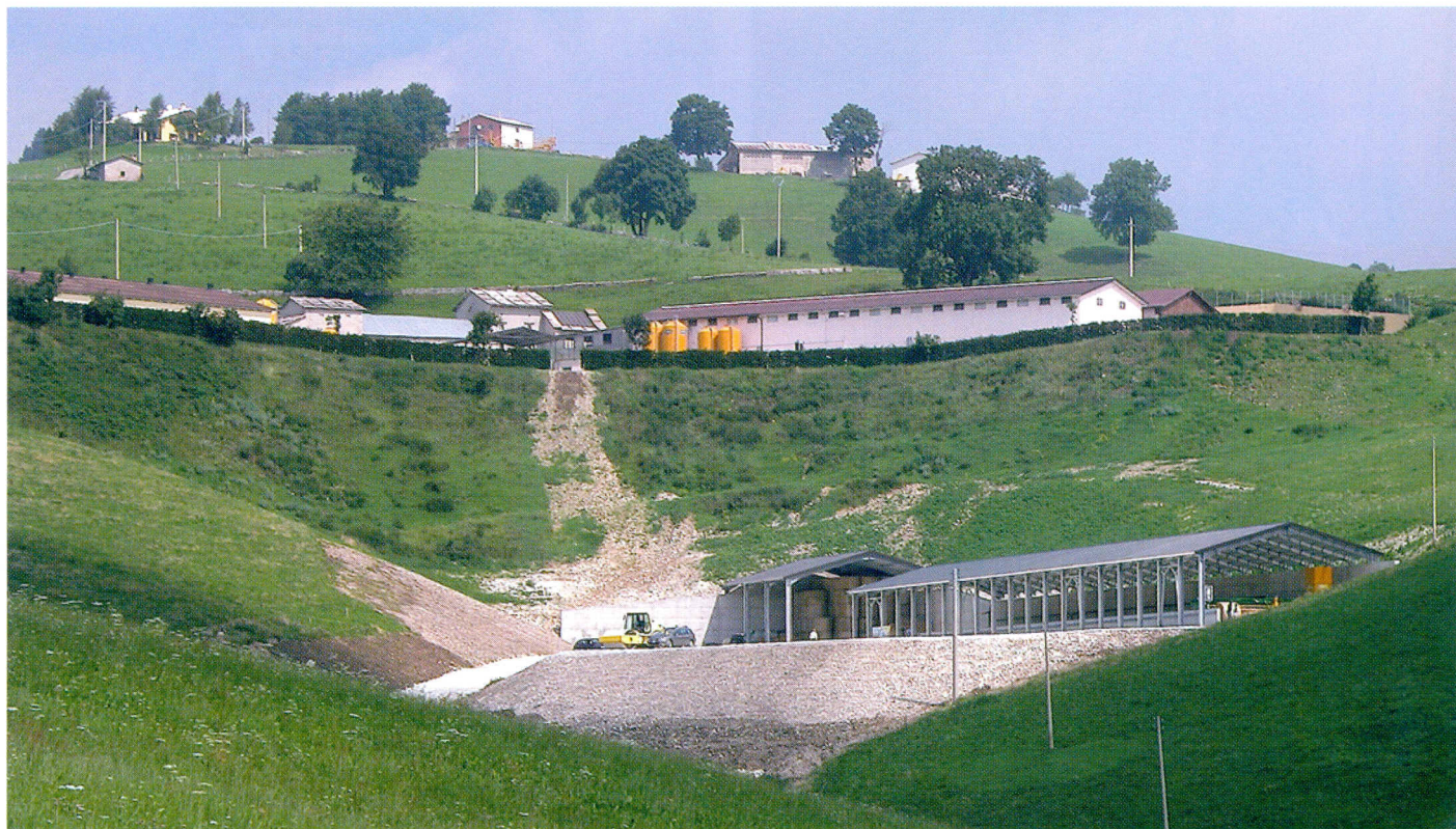
▼ Una vista d'insieme dell'azienda Faccio, a Bosco Chiesanuova in provincia di Verona. In alto si vedono i capannoni dell'allevamento e, in basso, la nuova struttura. La collocazione montana dell'impianto ha richiesto un imponente lavoro di sbancamento, per creare la superficie piana su cui edificare l'opera. Decisamente il risultato - anche come impatto visivo - è più che soddisfacente
